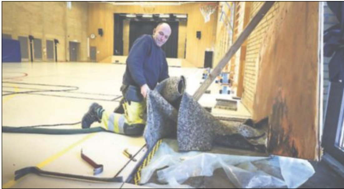
RIVER HELE HALLGULVET: Tirsdag startet servicesnekker Thomas Ender arbeidet med å rive hele gulvet i flerbrukshallen på Dalen skole - som er stengt på ubestemt tid. I løpet av noen uker skal arbeidet være ferdig.
